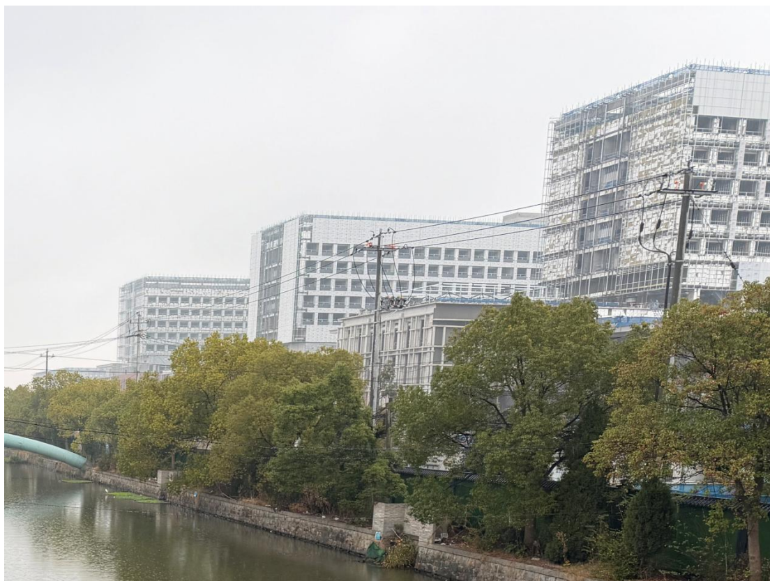
ZX图 1-2 在建浙一医院钱塘院区现状图
